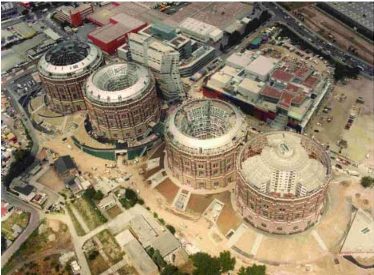
Bei den Wiener Gasometern handelt es sich um ziegelummantelte Behältergebäude, in deren Inneren jeweils ein dreiteiliger Teleskopbehälter aus Stahl zur Speicherung des Gases diente. Der Innendurchmesser jedes Gasbehälters beträgt 62,85 m, die größte Innenhöhe etwa 72,5 m. Besser als diese Zahlen veranschaulicht aber vermutlich ein Vergleich die gigantischen Ausmasse der Gasbehälter: Das Wiener Riesenrad würde in jeden dieser Behälter Platz finden.
