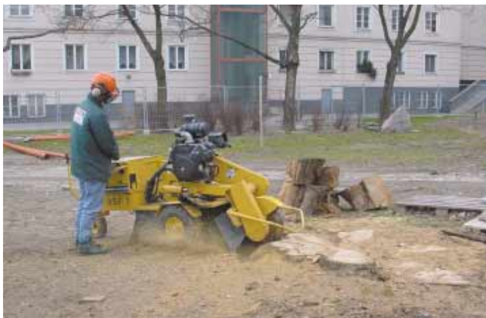
Wurzelstockfräse im Einsatz
