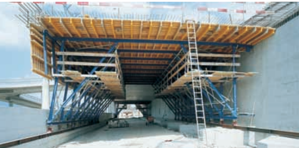
Das schätzen die Schweizer an den Tunnel-Lösungen der Holzco-Doka: Hier eine Portalwagen-Lösung für die Galerie Leuzigen mit satten 20 m Abschnittslänge, mit 11,70 m Breite und angehängten Klapp-Elementen, die nochmals 2 m Breite bringen. Das Ganze wird auf 4 Wälzswagen komplett verschoben.
