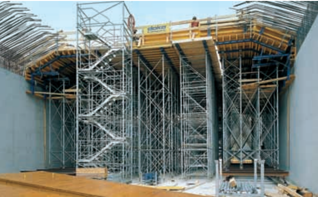
In offener Bauweise und ungewöhnlichen Takten entsteht dieser Rechteck-Tunnel in der Nähe des Bahnhofs von St. Anton am Arlberg. Von den 3 Traggerüst-Einheiten mit den geraden Deckenschalungs-Elementen bleiben die äußeren als Hilfsunterstützung stehen.
