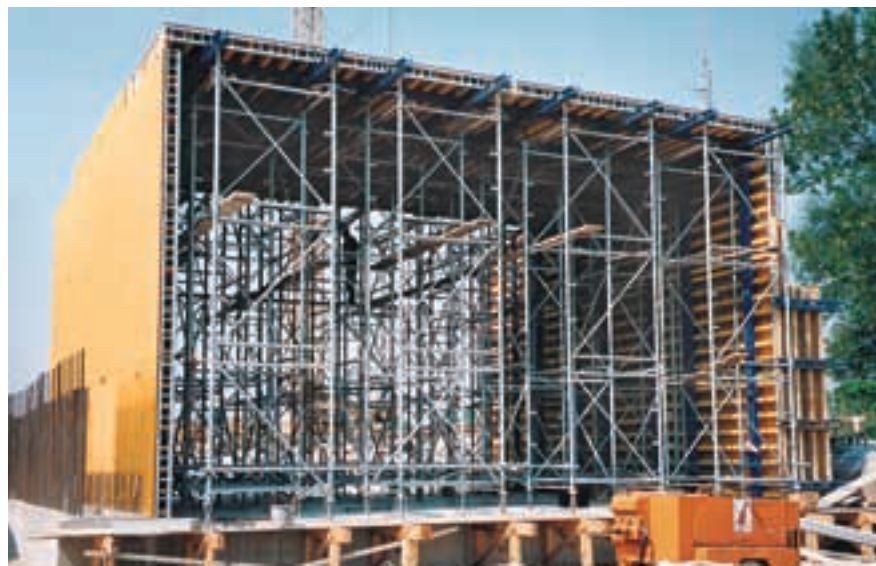
Eine Komplettlösung für einen S-Bahn-Tunnel am Münchner Flughafen: Eine Staxo-Traggerüst-Einheit trägt die Deckenschalung aus Fertigelementen der Trägerschalung FF 20 - daran abgehängt die Seitenschalung. Nach Absenken der Turmreihen und Heranziehen der Außentürme fährt der gesamte Querschnitt einen Abschnitt weiter.
