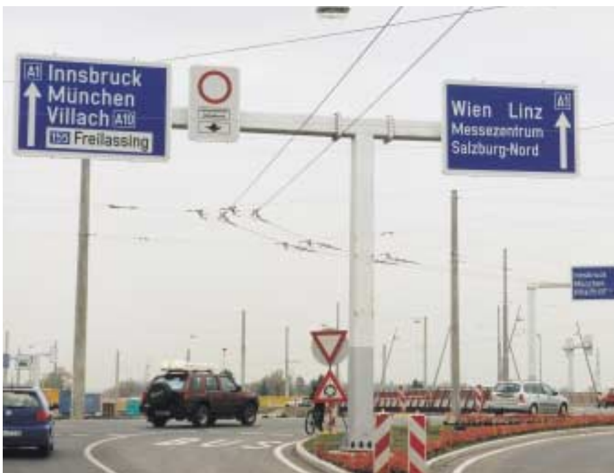
Der neue Verteilerkreis der Anschlußstelle Salzburg Mitte
