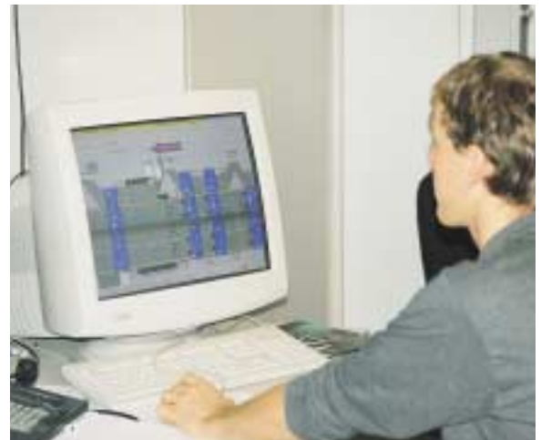
Bedieneinheit in der Tunnelleitzentrale.
