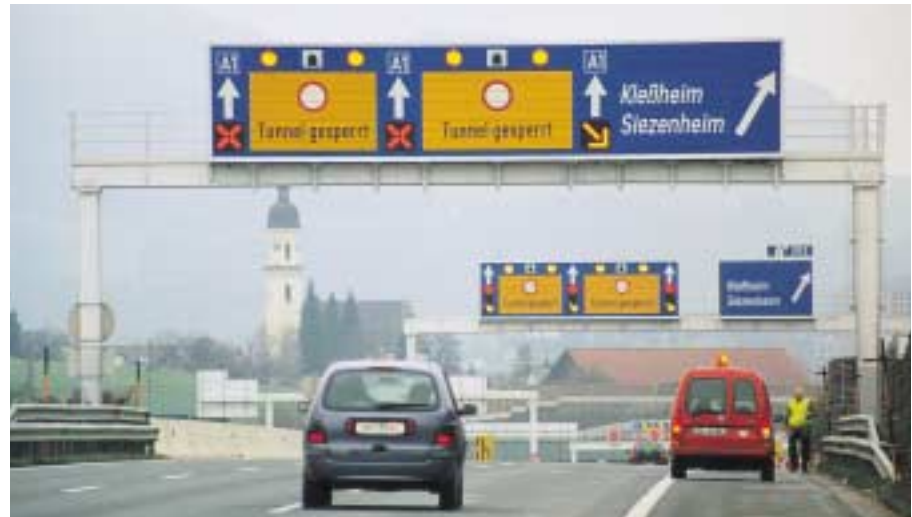
Schilderbrücke mit Wechselwegweiser in Prismentechnik und Fahrstreifensignalen.
