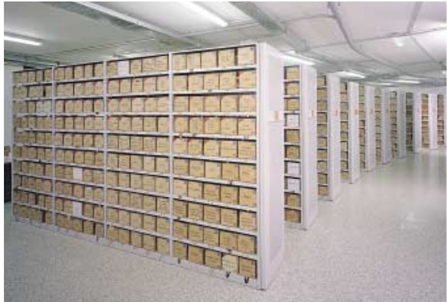
Fachbodenregale für den Kernbereich des 4. Archivgeschoßes in Ebene 8.
