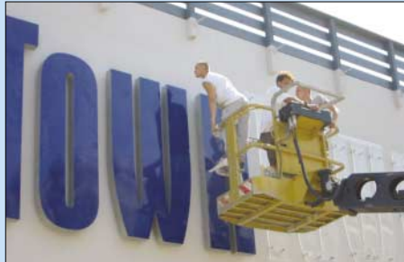
Letzte Vorbereitungen in schwindliger Höhe: Das TownTown-Logo wird montiert.
