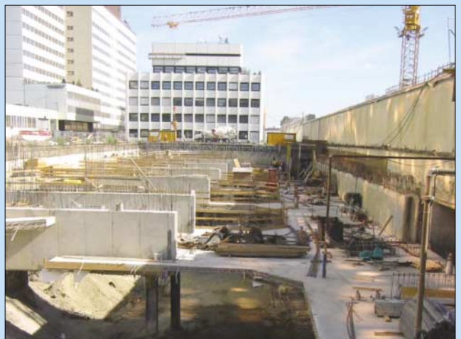
Baubeginn für TownTown-Garage
