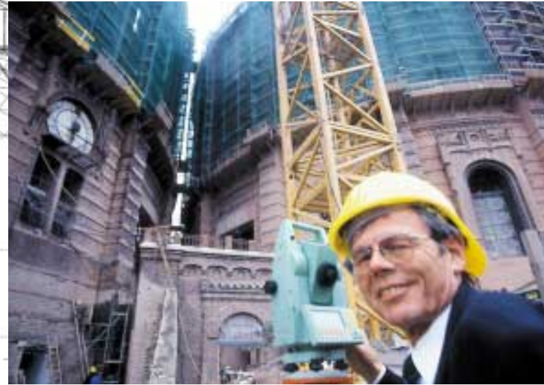
Links: Porr Chefvermesser Hans-Peter Blaha bei der schnellen berührungs- und reflektorlosen Erfassung der Gasometerstruktur. Ganz unten: Porr Vermessungsingenieur Stefan Götz kontrolliert mit dem LEICA TCRA1105 alte und neue Baustrukturen.
