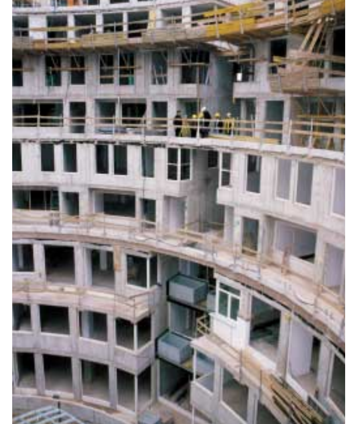
Links: Porr Chefvermesser Hans-Peter Blaha bei der schnellen berührungs- und reflektorlosen Erfassung der Gasometerstruktur. Ganz unten: Porr Vermessungsingenieur Stefan Götz kontrolliert mit dem LEICA TCRA1105 alte und neue Baustrukturen.
