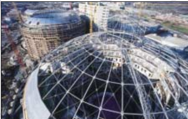
Wiedermontage der Kuppelkonstruktion • Re-erection of the dome structures
