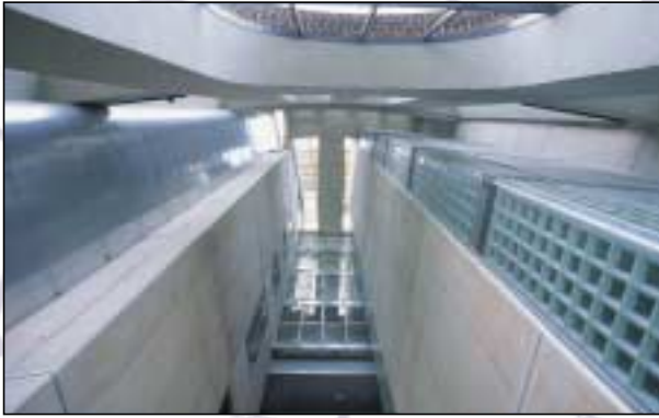
Fassade mit Glasbausteinen • Façade with glass bricks
