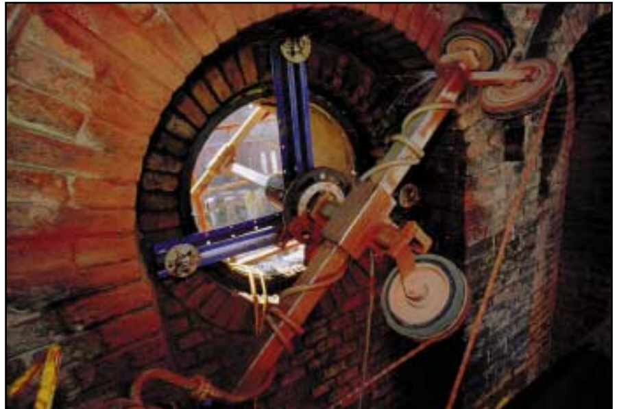
3 Zirkelsäge beim Trennen der Rundbogenfenster
