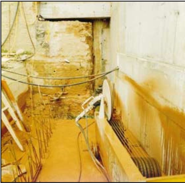
2 Einbringen von Öffnungen in das Fundament
